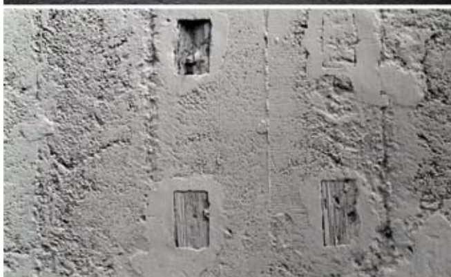
10. Technologia – odsłonięcie konstrukcji i pokazanie materiałów i instalacji, pokazanie śladów historii użytkowania obiektu, foto. Paweł Wład Kowalski
