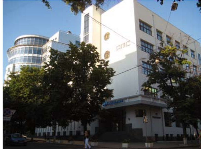
10. Automatyczna Centrala Telefoniczna, stan obecny. Fot. S. Smolenska, 2009
