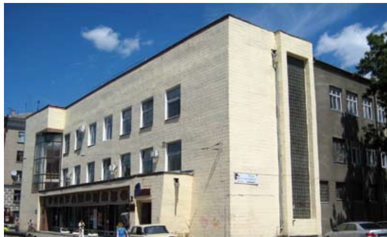
8. Klub Budowlanych, stan obecny. Fot. S. Smolenska, 2009
