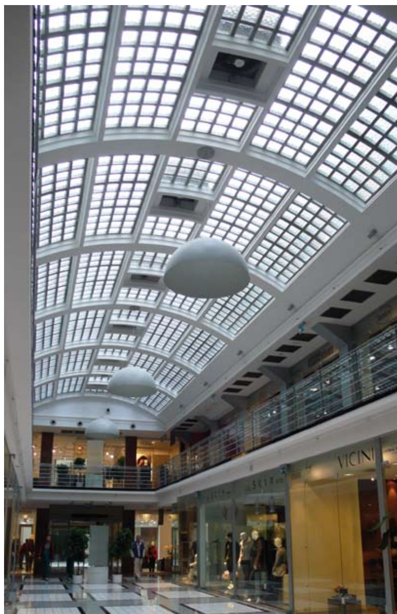
6. Pasaż Centralny w Bratysławie po renowacji przeprowadzonej w 2005-06 r. (fot. V. Kapišinská, D. Haberland)
