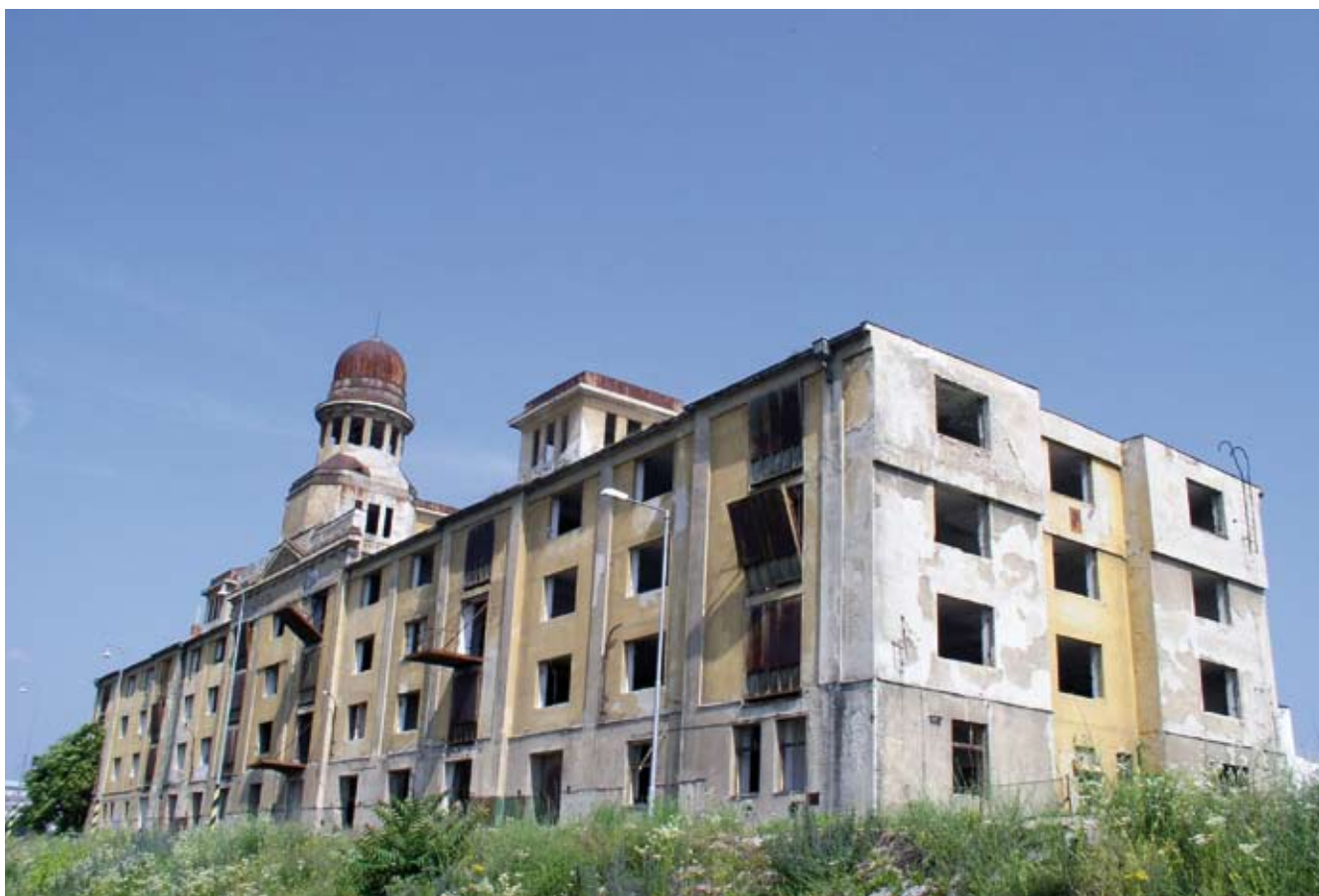
7. Opuszczony magazyn nr 7 przed renowacją (Karol Skorovský 1921-22)
