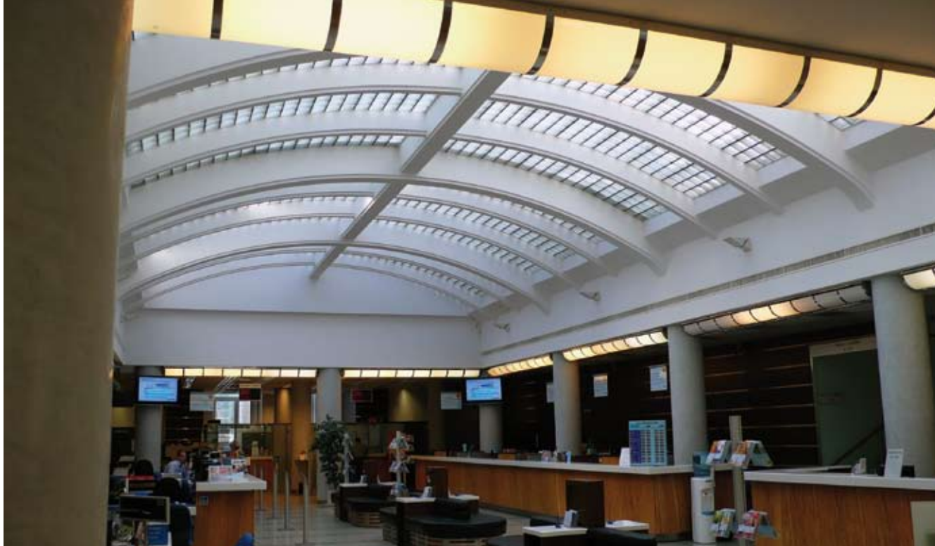
3. Betonowo-szkłane sklepienie sali operacyjnej Słowackiego Banku Oszczędności w Bratysławie (fot. V. Kapišinská, D. Haberland)
