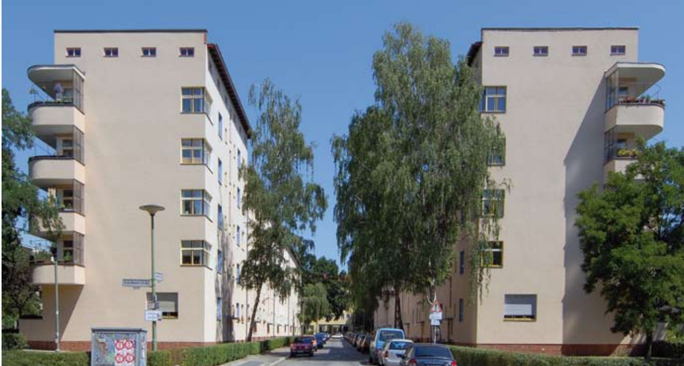
7. Narożny budynek rzędu pięciokondygnacyjnych budynków osiedla Carl Legien projektu Bruno Tauta. Fot. Wolfgang Bittner (Landesdenkmalamt Berlin)
