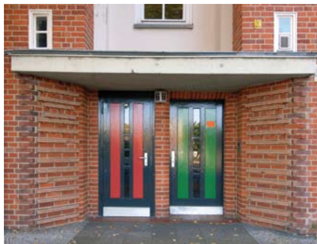
5. Wejścia na osiedlu Schillerpark, nazywanego Osiedlem Holenderskim, ze względu na ceglane elewacje, proj. Bruno Taut. Fot. Wolfgang Bittner (Landesdenkmalamt Berlin)
