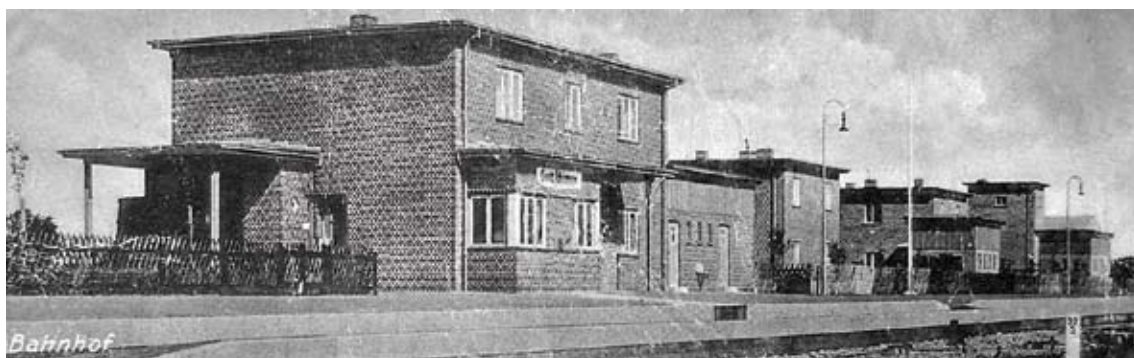
2. Stacja w Gościmiu. Widok od strony torów. Na pierwszym planie dworzec, dalej budynki mieszkalne, w tyle wieża ciśnień, około 1938 (Widokówka, archiwum autorki)
