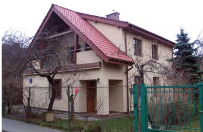
10. Wystawa Budowlano-Mieszkaniowa Banku Gospodarstwa Krajowego w Warszawie na Kole (1935). Dom wolnostojący typu BGK 13 (proj. T. Cwierzdzkiński i R. Gürtler). Dom nr 29 przy ul. Dalibora – stan w 1935. Dom po przebudowie (ul. Dobrogniewa 7) – stan w 2007. Wg Katalog Wystawy Budowlano-Mieszkaniowej Banku Gospodarstwa Krajowego w Warszawie na Kole maj – sierpień 1935, Warszawa 1935; fot. autorki.
