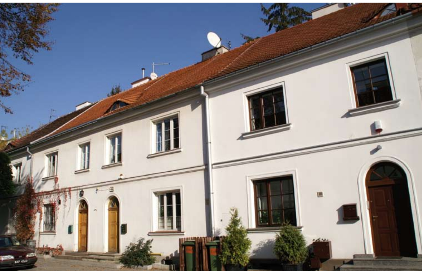
2. Domy typu szeregowego przy ul. Brodzińskiego w Kolonii Urzędniczej na Żoliborzu (1921-1922) w Warszawie. Zróżnicowana obecnie kolorystyka stolarki. Fot. J. Roguska, 2009
