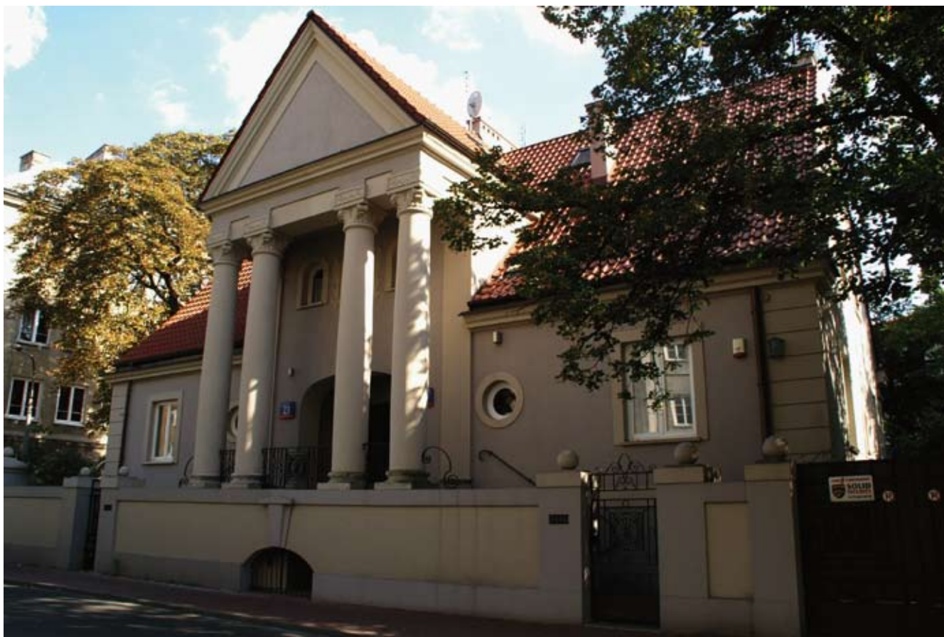
3. Powtarzalny dom bliźniaczy w Warszawie przy ul. Mochnackiego 23/25, wg projektu arch. Romualda Millera, 1924. Fot. J. Roguska, 2009
