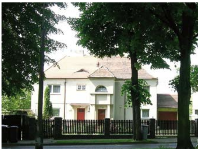
2. Postmodernistyczna przebudowa (rok 1992) budynku w osiedlu z lat 20. XX wieku, w Gliwicach przy ul. Mickiewicza (fot. autorka, 2008).
