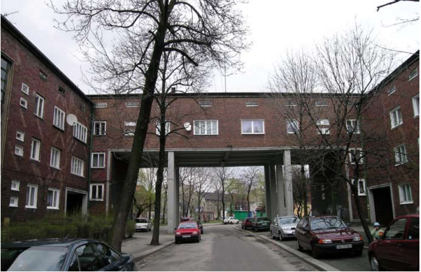
10. Zespół przy Placu Słowiańskim. Widok od strony wnętrza zespołu. Różnorodne podziały nowych okien zaburzają pierwotną harmonię elewacji budynku (fot. autorka, 2007).
