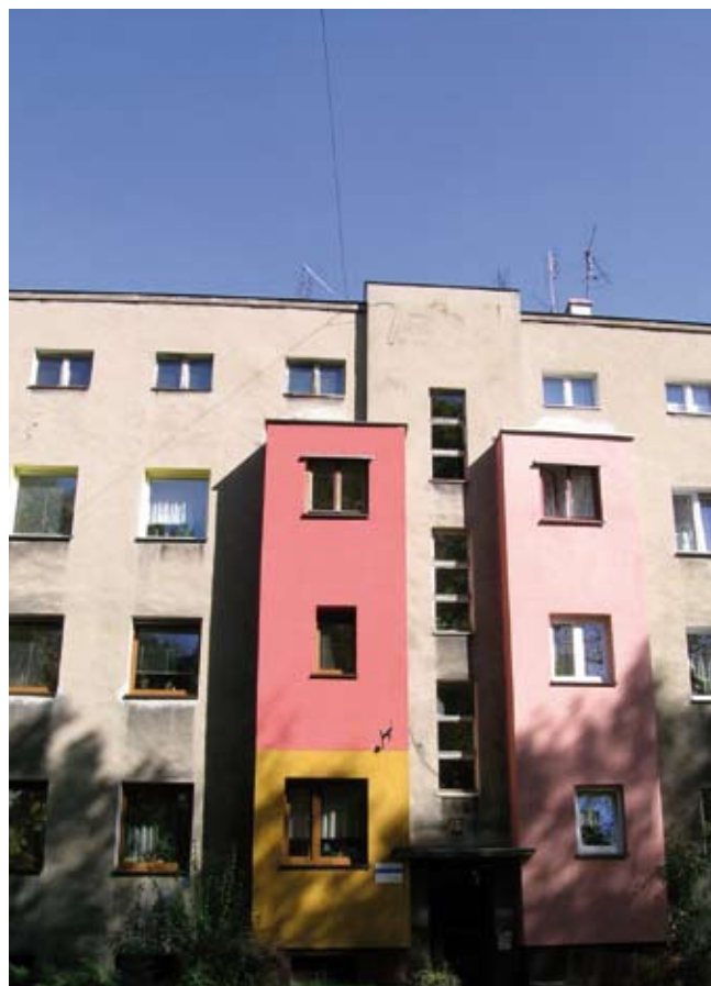
8. Blok mieszkalny przy ul. Mikulczyckiej, widoczne zabudowane w latach 60. loggie (fot. autorka, 2007).
