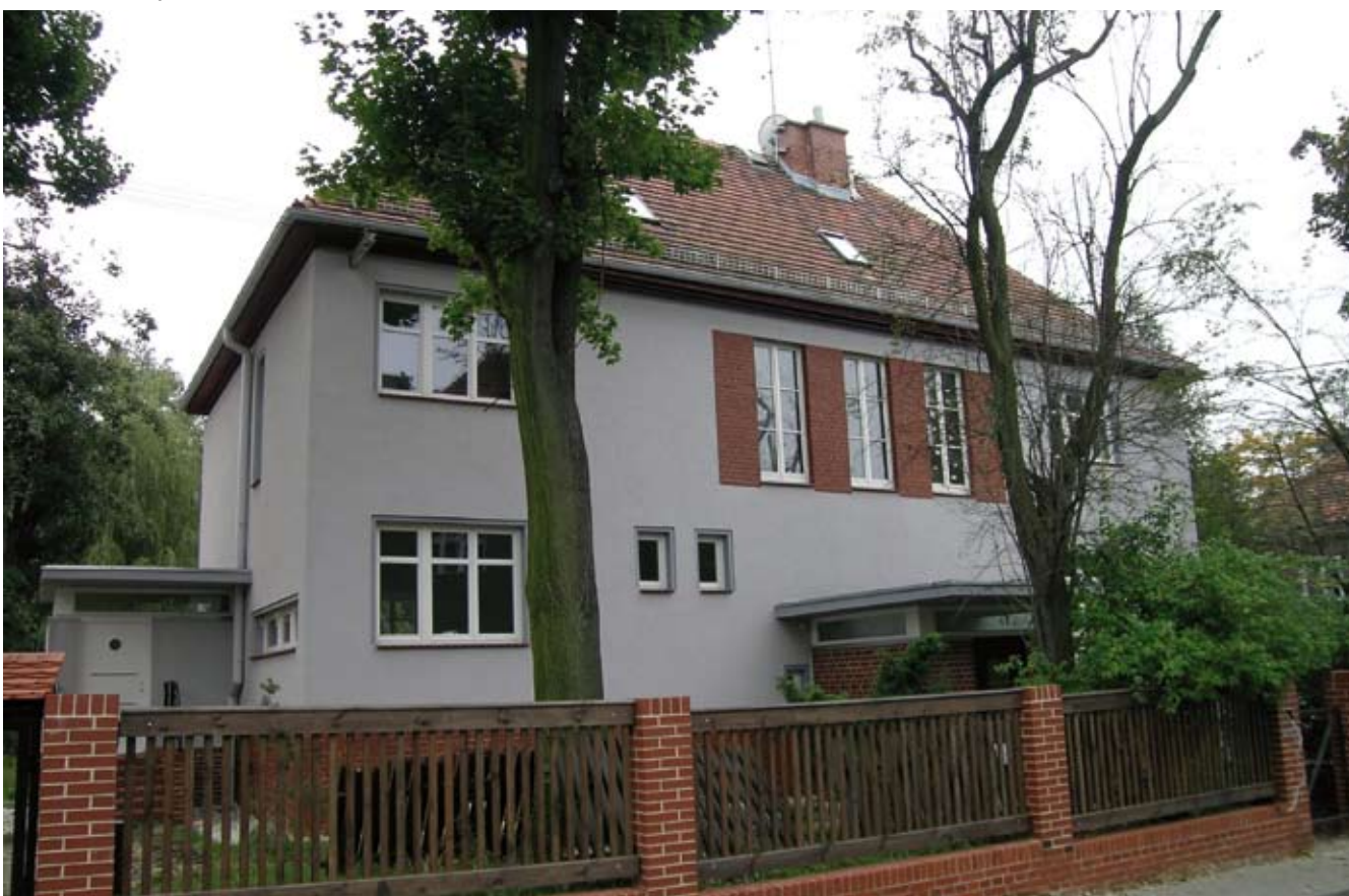
3. Modernizacja budynku w osiedlu z połowy lat 20. XX wieku, w Gliwicach przy ul. Ligonja. Widać duże staranie o zharmonizowanie nowych elementów z pierwotnym stylem budynku. Nowe okna, jak i przeszła płotu, odwzorowują historyczną formę, na dachu pozostawiono oryginalną dachówkę, wiatrołap dostosowano stylistycznie do budynku. Jest to przykład coraz wyraźniejszej tendencji do uznania za wartościową zabudowę mieszkaniową, pochodzącą z okresu międzywojnia. Dzięki niej zauważalne jest podczas zabiegów modernizacyjnych, większe poszanowanie pierwotnej formy i detalu budynków (fot. autorka, 2007).
