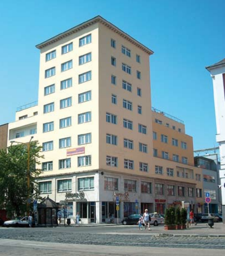
11. „Osmiopietrowiec” po renowacji – stan obecny. (Fot. Zuzana Labudová)
