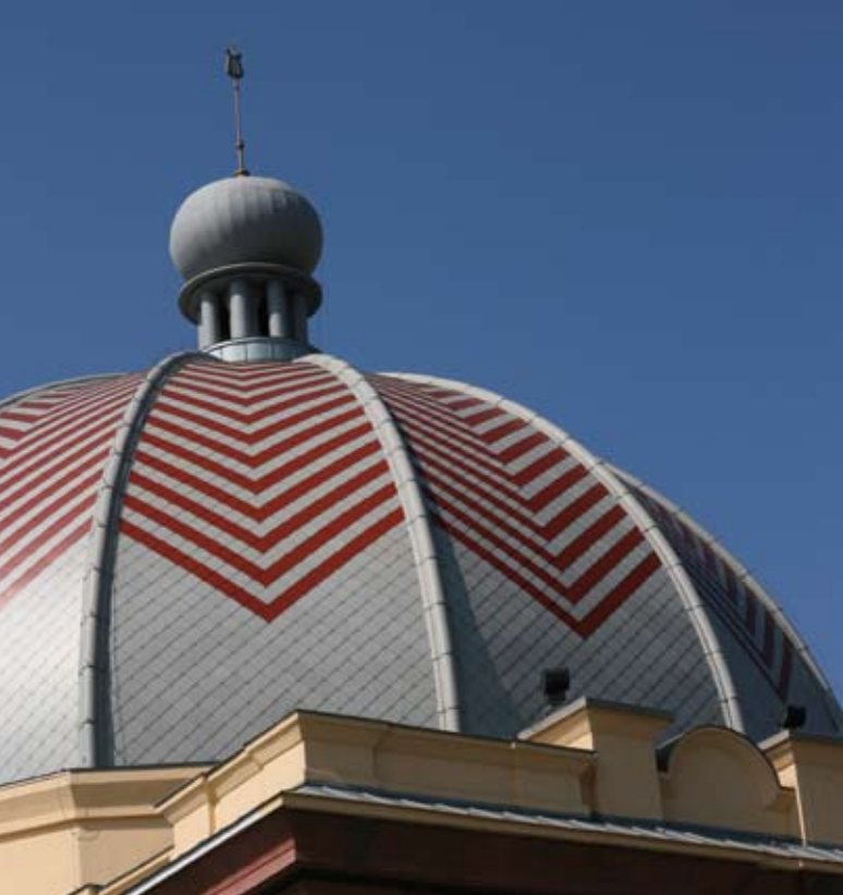
6. Dach kopuły po zakończeniu prac. (Fot. Alena Hrabinská)
