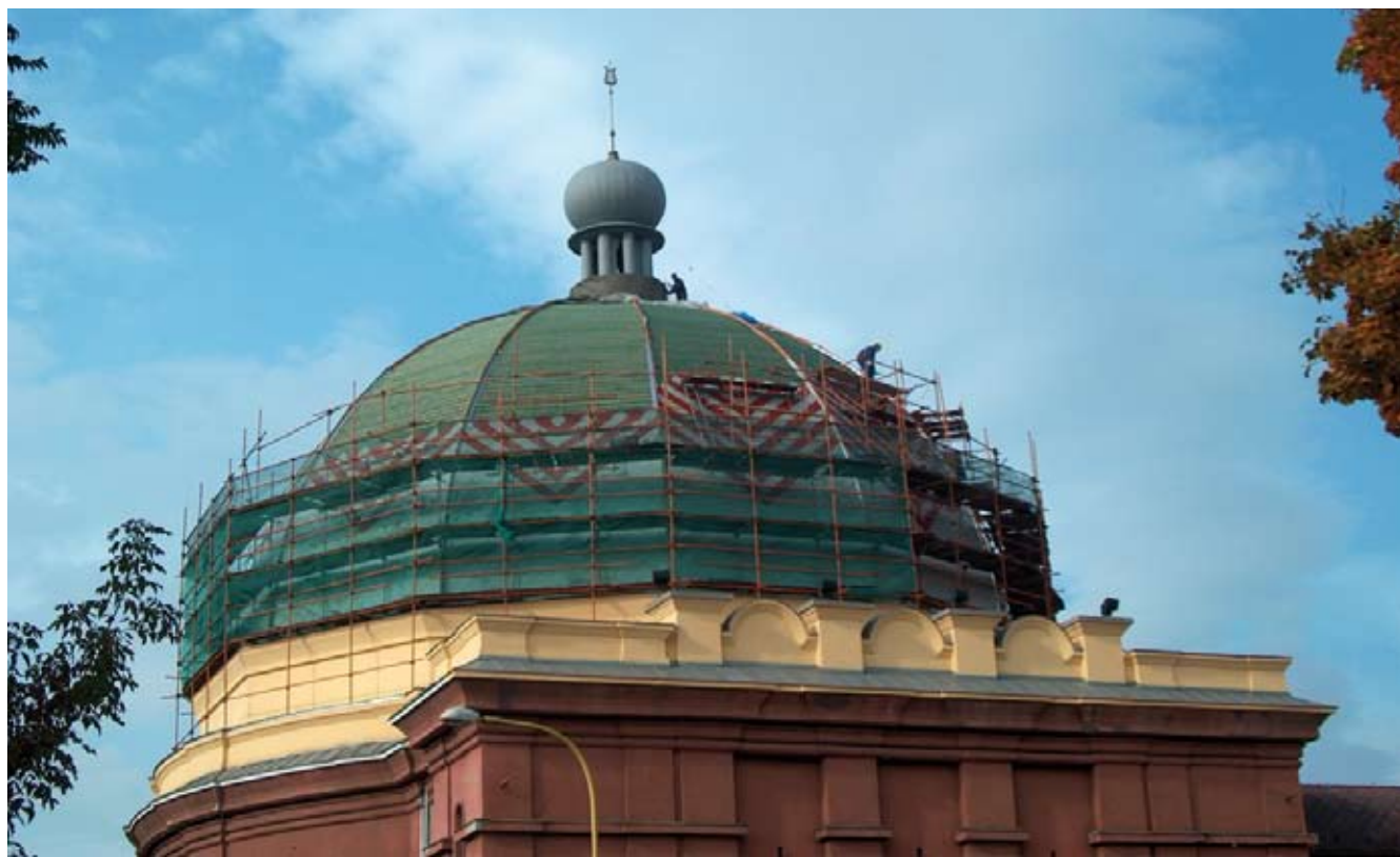
5. Prace konserwatorskie na dachu kopuły w 2005 roku. (Fot. Zuzana Labudová)
