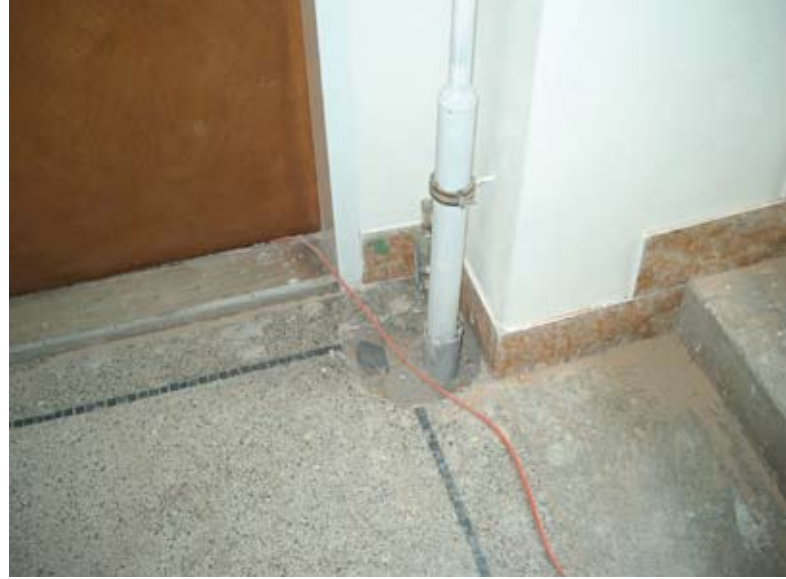
9. Fragment posadzki z lastryko na klatce schodowej, zniszczonej podczas renowacji budynku. (Fot. Zuzana Labudová)
