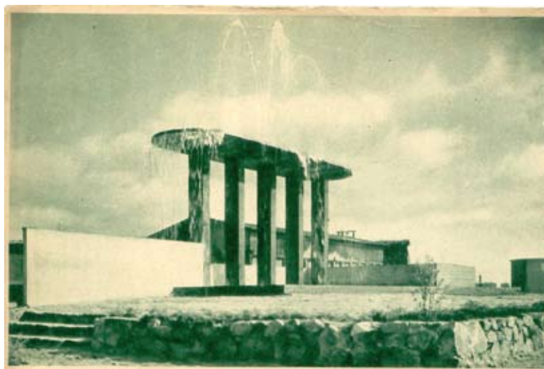
4. Kaskada termalna - fontanna napowietrzająca solankę w celu odżelazienia. Poniżej taras plaży piaskowej. (Pocztówka ze zbiorów autorki).
