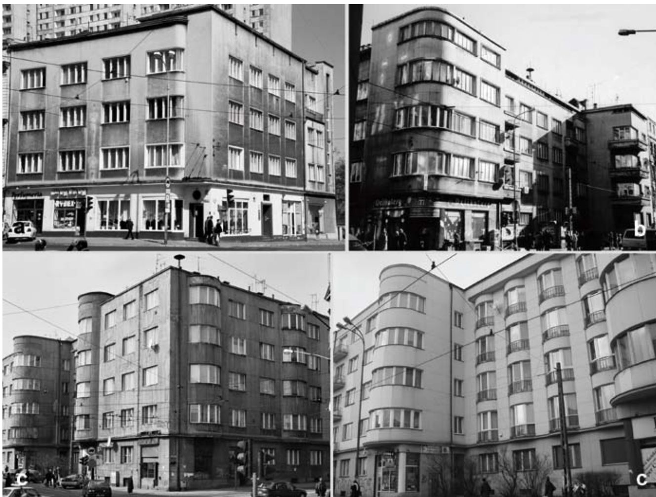
4. a. Kamienica narożna, Łódź ul. Piotrkowska 196 róg ul. Wigury; b. Kamienica narożna, Łódź, ul. Kilińskiego 82 róg ul. Tuwima; c. Kamienica narożna, Łódź, ul. Gdańska 55 róg ul. Zielonej (fot. autorka)
