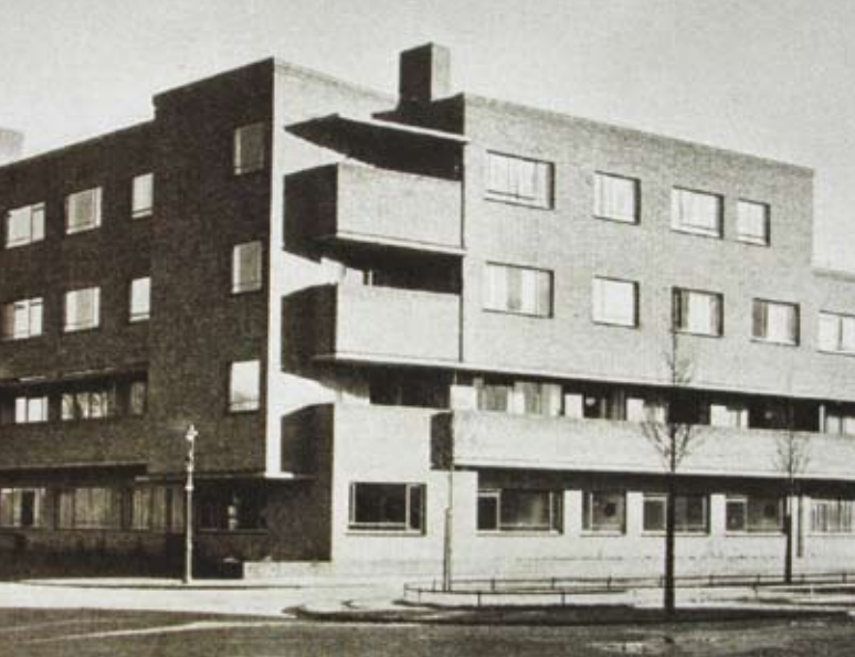
3. Voorburg, budynek mieszkalny, arch. Jan Wils, 1926 (wg „Moderne Bauformen”, 1927)
