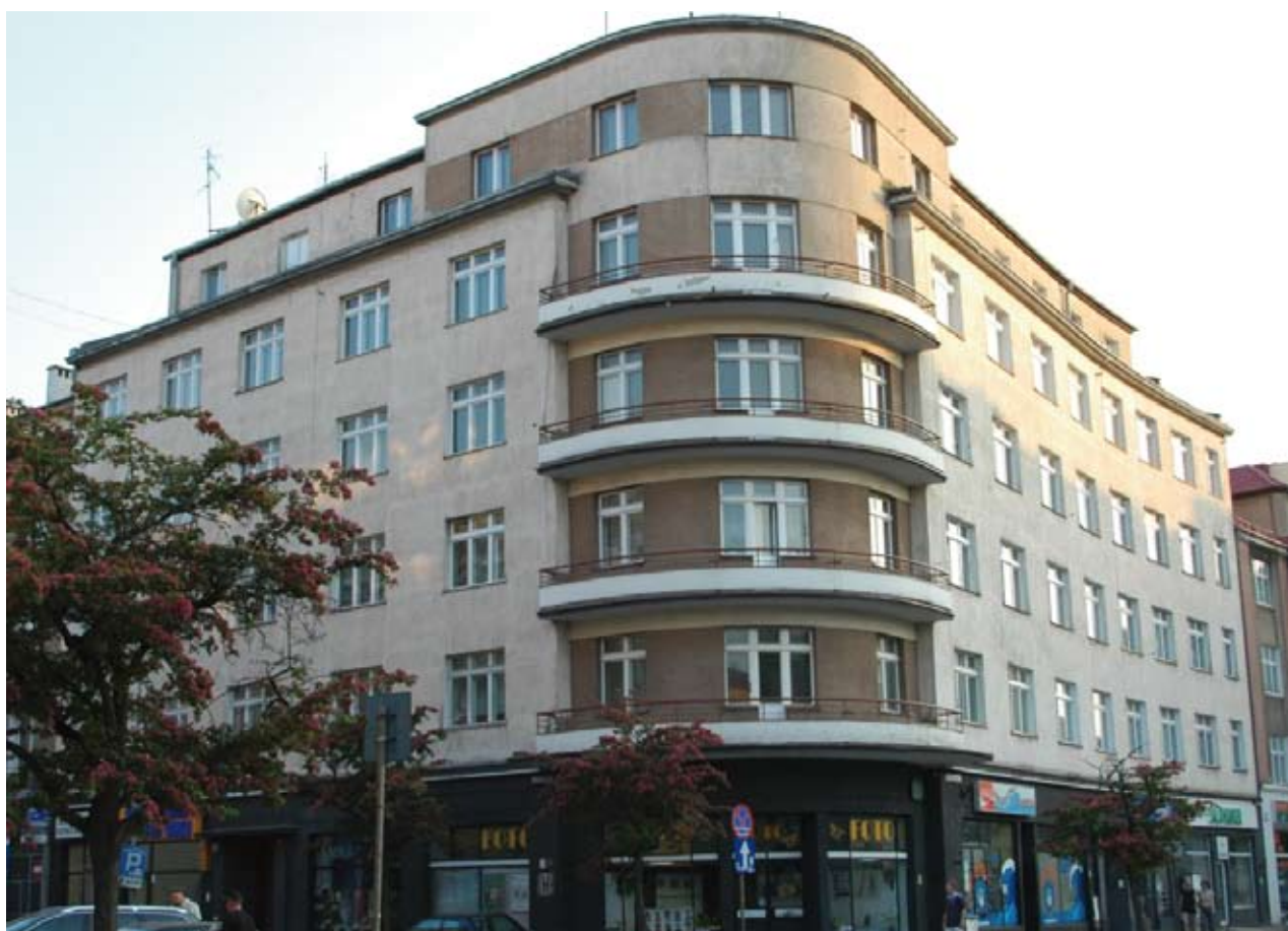
8. Gdynia, kamienica przy ul. Starowiejskiej 7, arch. Marian Maśliński, 1932 r. (fot. Maria. J. Soltysik)
