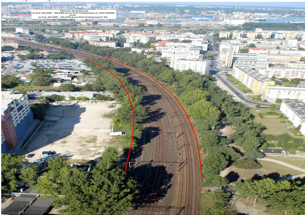
◆ Rysunek 18: Modernizacja linii kolejowej Warszawa – Gdynia [Źródło: Materiał własny PKP PLK S.A.]
