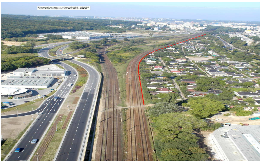
◆ Rysunek 16: Modernizacja linii kolejowej Warszawa – Gdynia [Źródło: Materiał własny PKP PLK S.A.]
