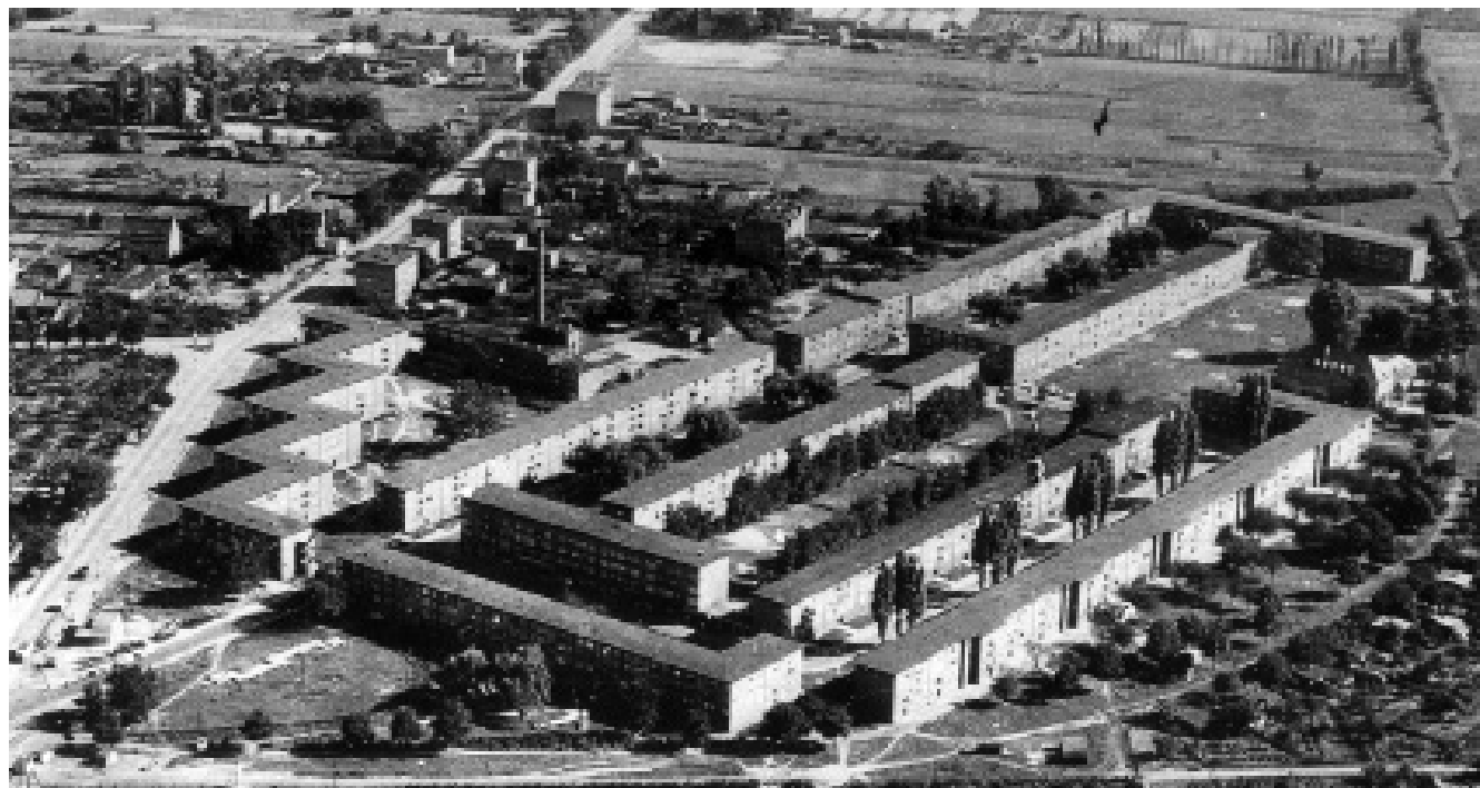
10. Linear-type settlement of Księżę Małe (formerly Klein Tschansch ), architects P. Heim, A. Kempter, 1928. Source: Architektura Wrocławia , vol.2, Urbanistyka , Wrocław 1995
