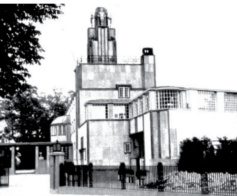
1. Brussels, Stoclet Palace, architect Joseph Hoffmann, 1905-1914 (source: L. Benevolo, Geschichte der Architektur des 19. und 20. Jahrhunderts , Munchen 1964, p. 362)
