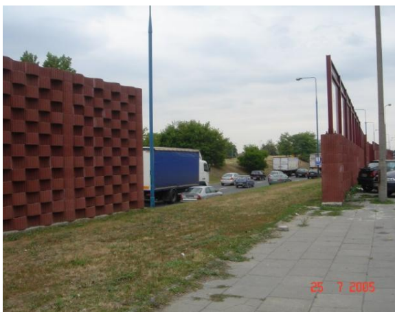
Rys. nr E 9 Zbyt duża przerwa zmniejsza skuteczną ochronę przed hałasem
