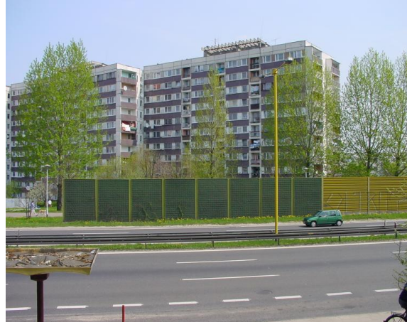
Rys. nr E 5 Ekran akustyczny „chroniący” wieżowce
