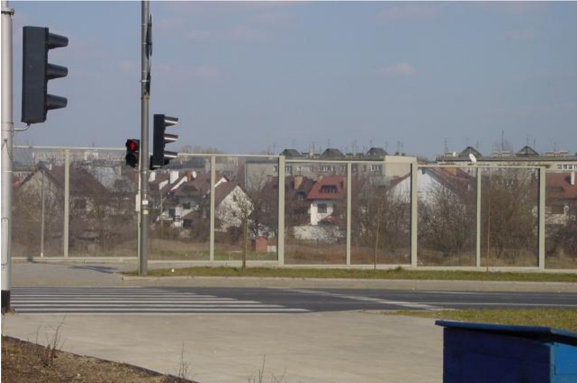
Rys. nr E 11. Zastosowanie ekranu akustycznego do ochrony osiedla przed hałasem
