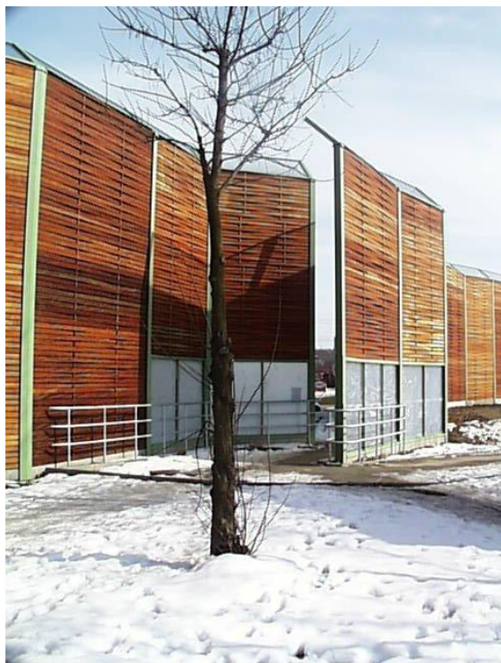
Rys. nr E 10 Przykład właściwego zaprojektowania przejścia w ekranie
