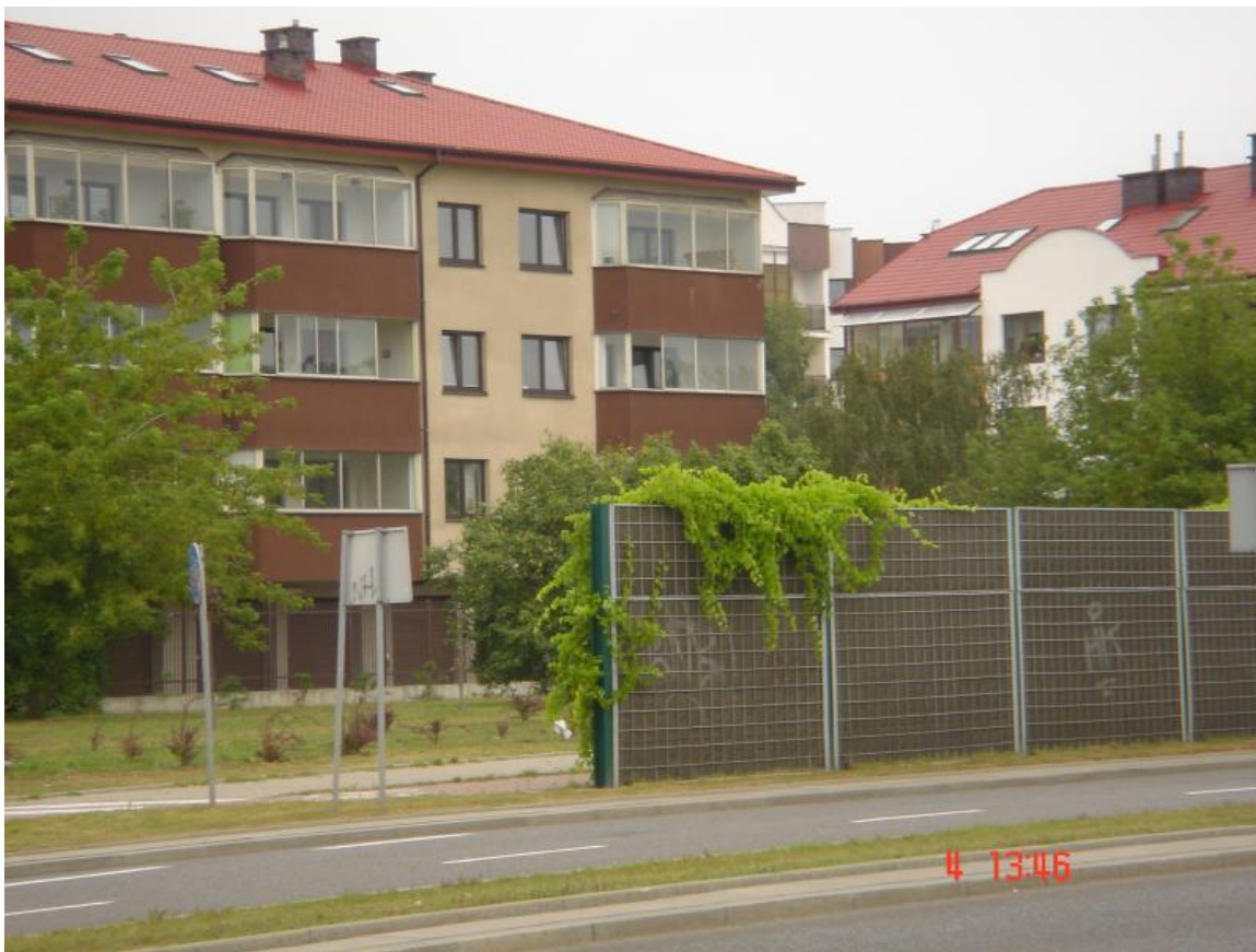
Rys. nr E 8 Przykład zbyt krótkiego ekranu akustycznego
