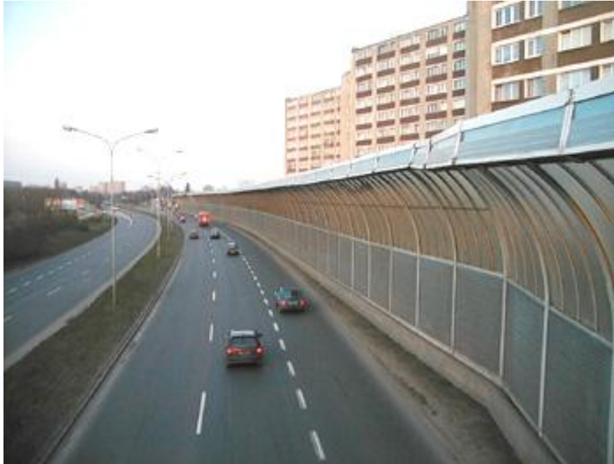
Rys. nr E 17 Ekran akustyczny łukowy chroniący wysoką zabudowę (Poznań)
