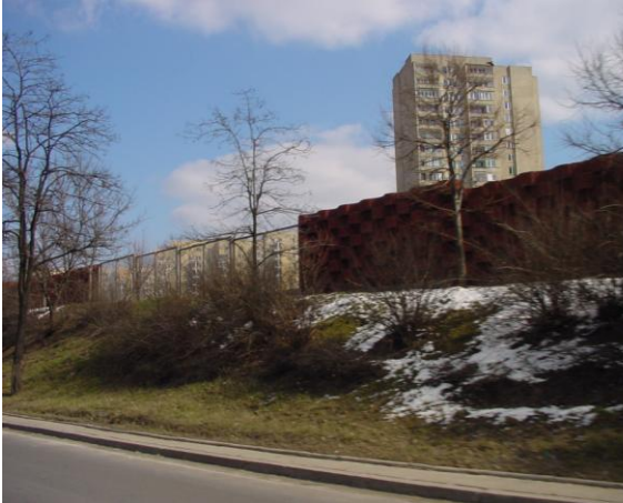
Rys. nr E 4 Ekran akustyczny na wale
