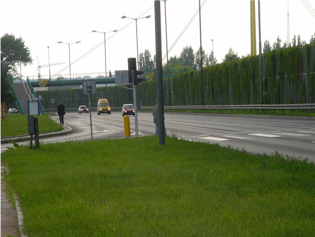
Rys. nr E 18 Ekran akustyczny pokryty roślinnością
