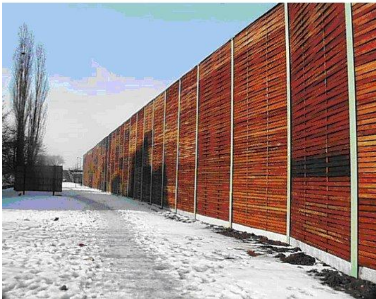
Rys. nr E 3 Wysoki ekran akustyczny
