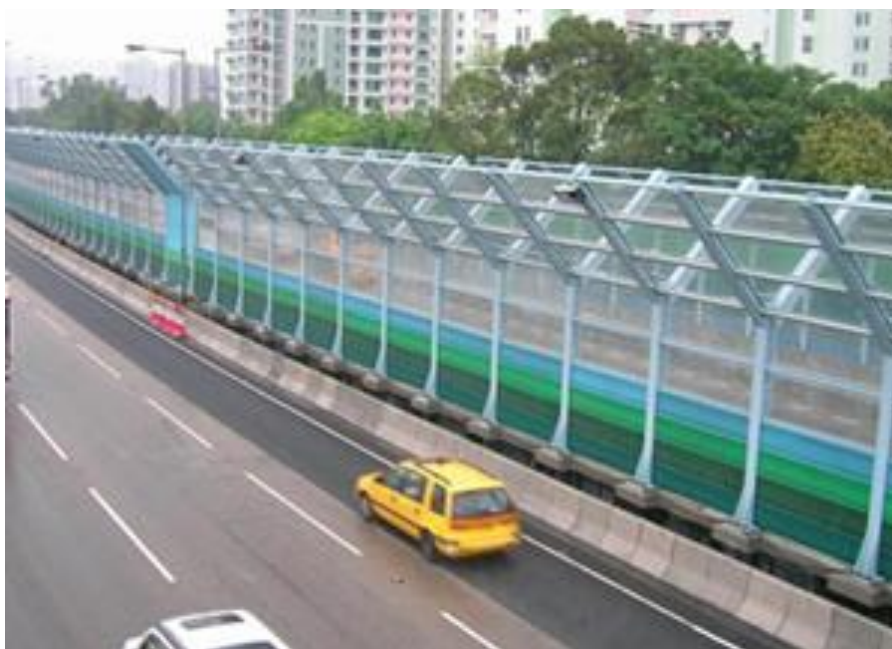
Rys. nr E 16 Ekran akustyczny w kształcie litery Y umieszczony w pasie dzielącym jezdnie.
